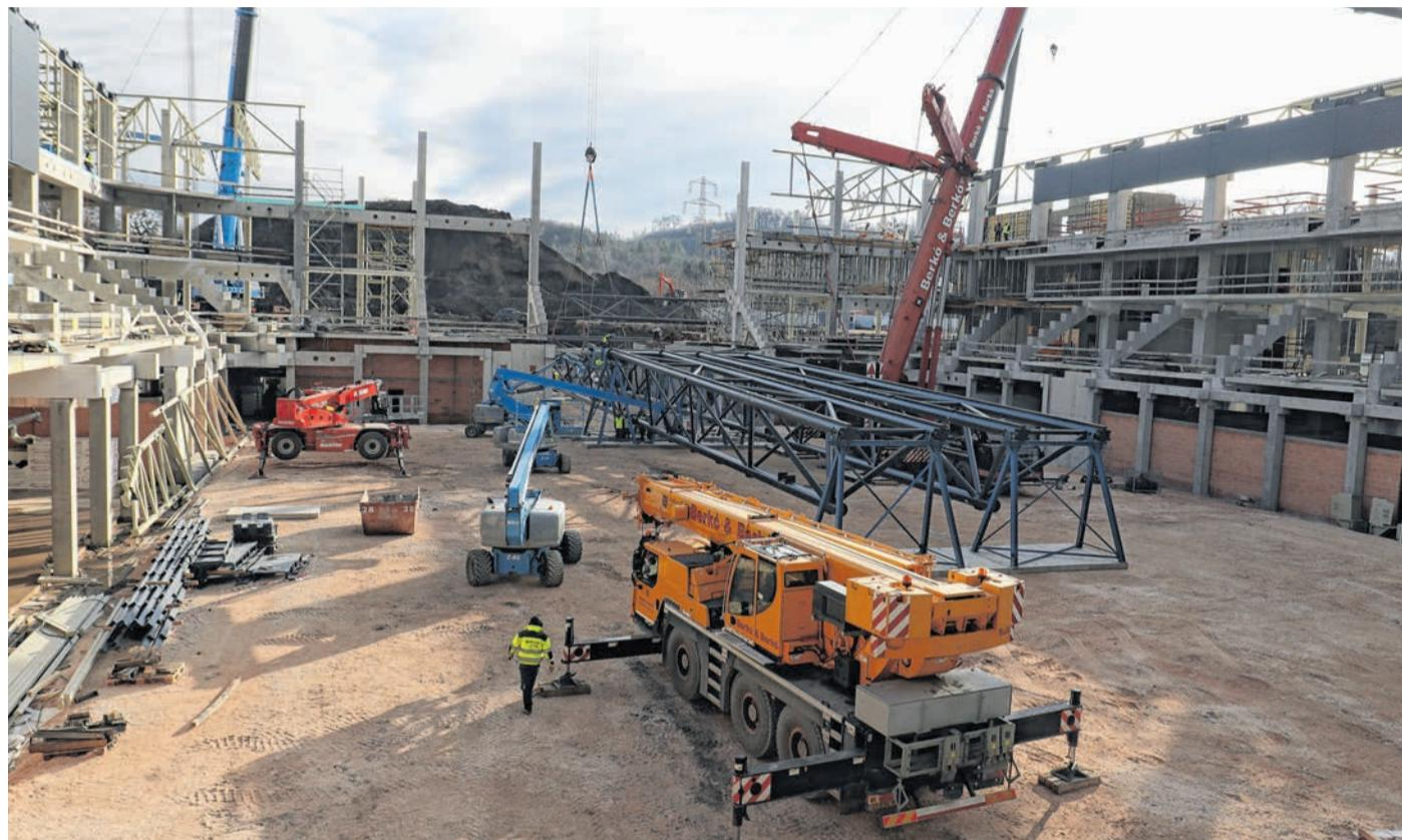
Négyszáz tonnás daru emeli a helyére a hatalmas acélszerkezeteket a csarnok leendő küzdőterén állva
